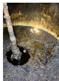
酸発酵槽内観
