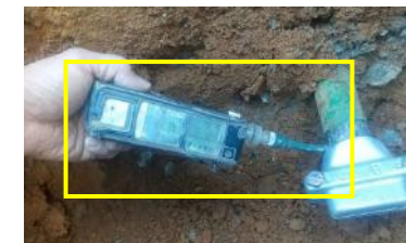
検知器による漏えい調査の実施
