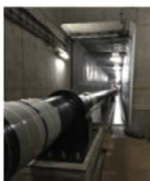
尼崎・久御山ライン（工事状況）
