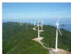
広川明神山風力発電所
