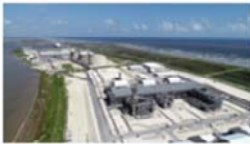
フリーポートLNGプロジェクト液化設備の第1系列 (Freeport LNG Development 社提供)
