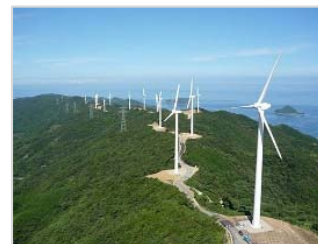
広川明神山風力発電所
