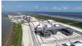
フリーポートLNGプロジェクト液化設備の第1系列 （Freeport LNG Development 社提供）
