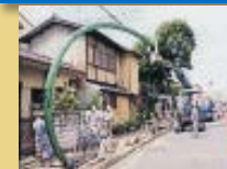
ガス導管の 耐震化対策
