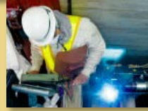
高圧幹線工事
