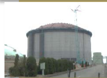
泉北製造所 第1工場5号タンク
