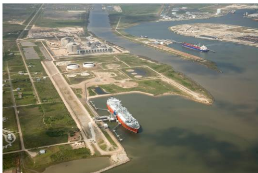
フリーポートLNG基地 (写真提供: Freeport LNG Development L.P.)
