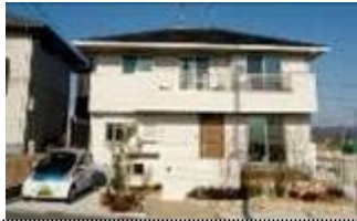
実験住宅(王寺)における実証実験
