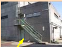
扉を水密扉に交換
