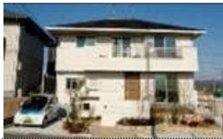
実験住宅(王寺)における実証実験
