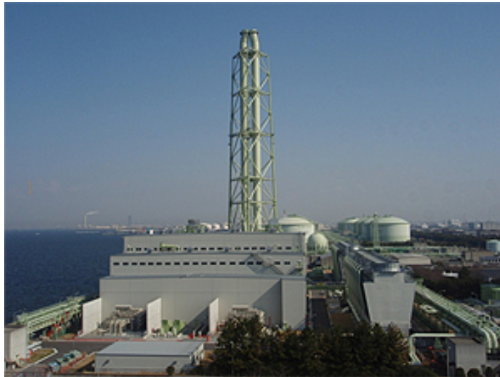
泉北天然ガス発電所
