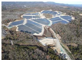
茨城県北茨城市磯原町特高発電所
