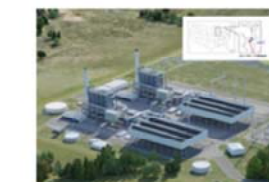
スリーリバーズ天然ガス火力発電所
