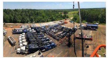
水圧破碎現場
