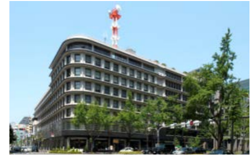
本社ガスビル（大阪市中央区）
