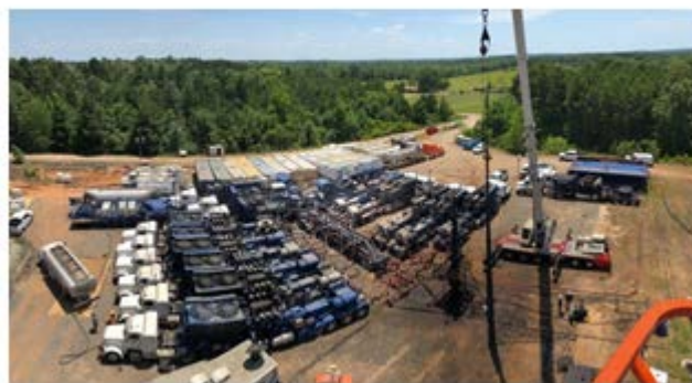
水圧破碎現場
