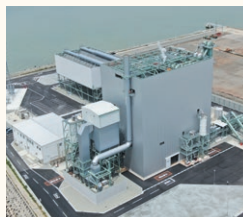
和歌山御坊バイオマス発電所
