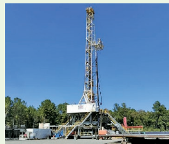
井戸掘削現場
