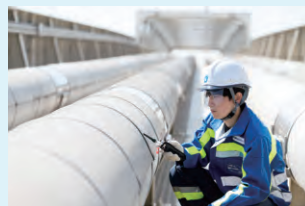
橋梁管の定期点検
