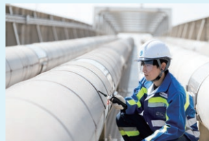
橋梁管の定期点検
