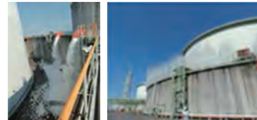
LNGタンクの防液堤に設置している高発泡設備および水幕設備
