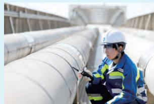
橋梁管の定期点検
