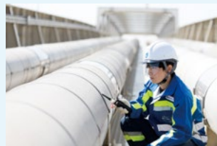
橋梁管の定期点検
