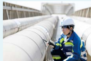
橋梁管の定期点検
