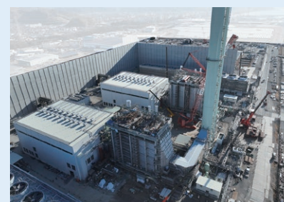
姫路天然ガス発電所
