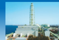
泉北天然ガス発電所
