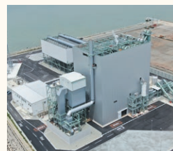
和歌山御坊バイオマス発電所
