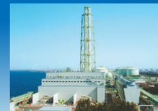
泉北天然ガス発電所
