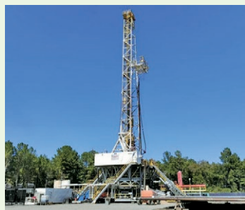
井戸掘削現場
