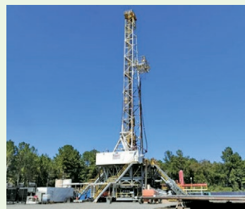
井戸掘削現場
