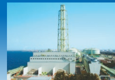
泉北天然ガス発電所
