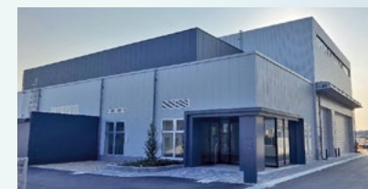
SOECメタネーションベンチスケール試験建屋(2025年6月 竣工)
