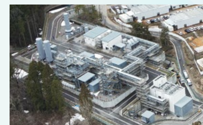
サバティエメタネーション実証設備を建設中
