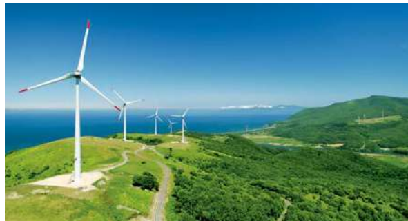
尻別風力発電所(北海道)
