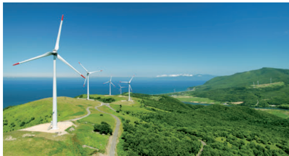
尻別風力発電所(北海道)
