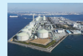
都市ガス製造所
