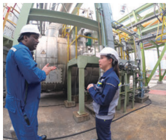
シンガポールの現場調査風景
