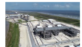
米国フリーポートLNG基地 Freeport LNG Development, L.P.提供
