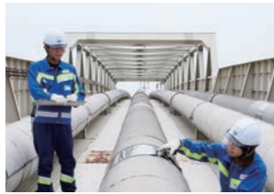
橋梁管の定期点検
