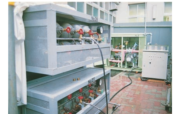
阪神・淡路大震災の際に設置したCNG ② による移動式ガス発生装置(上)と仮設風呂設備(下)
