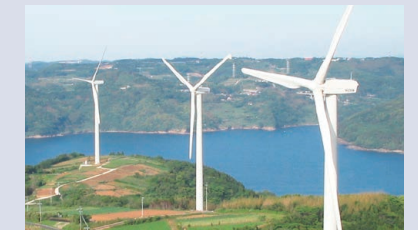
佐賀県唐津市の肥前風力発電所
