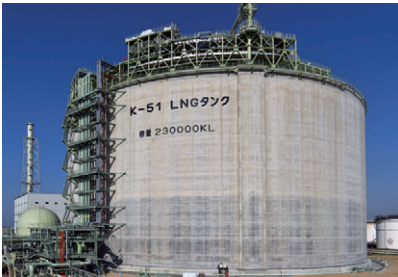
泉北製造所第一工場5号LNGタンク
