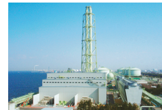
泉北天然ガス発電所(大阪府高石市)
