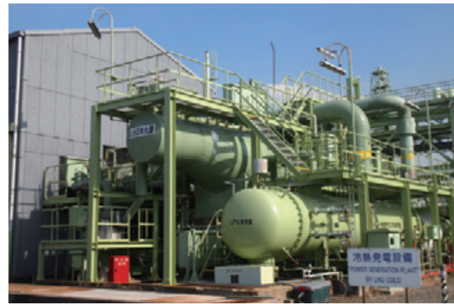
泉北製造所のLNG冷熱発電設備
