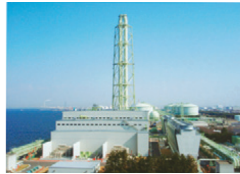
泉北天然ガス発電所(大阪府高石市)
