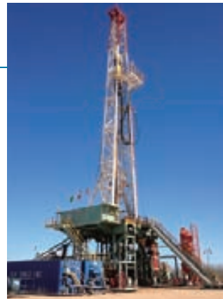
井戸を掘削中のリグ(掘削装置)
