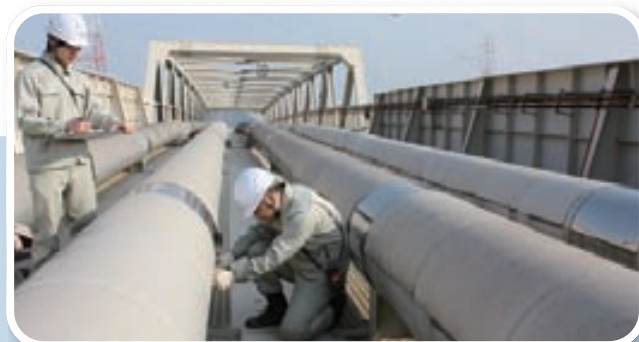
橋梁ガス管点検作業
