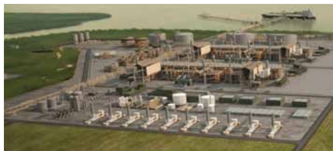
イクシスLNGプロジェクト
