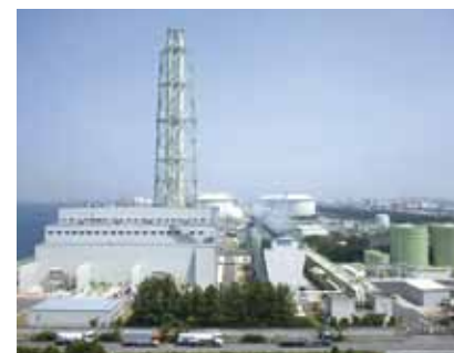
泉北天然ガス発電所
