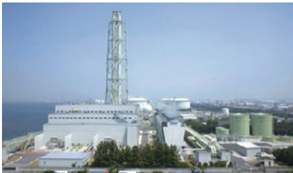
泉北天然ガス発電所
