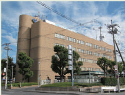
グリーンガスビル活動を推進する大阪ガス 北部事業所
