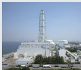
泉北天然ガス発電所
