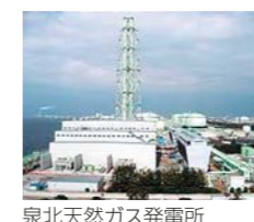
泉北天然ガス発電所
