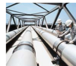
橋梁管の定期点検
