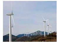
2006年3月に稼働を開始した高知県の葉山風力発電所
