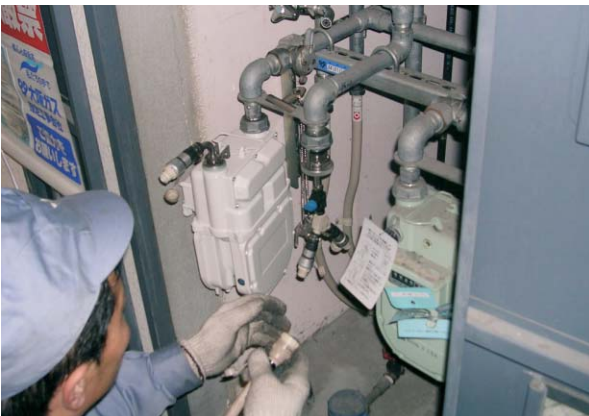
入室不要工法によるメーター取り替え
