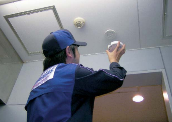
ガス警報器の取り替え
