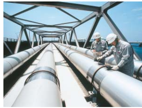
橋梁管の定期点検
