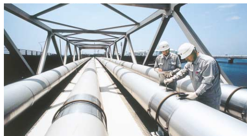
橋梁管の定期点検
