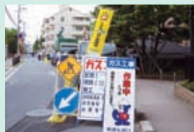
「こども110番の工事現場」ののぼりを立てたガス工事現場
