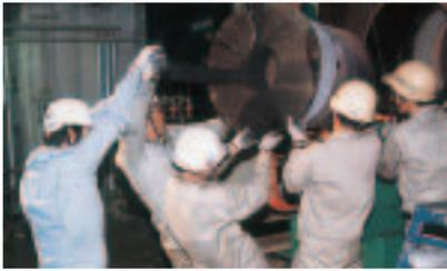
ボイラの天然ガス転換調整作業
