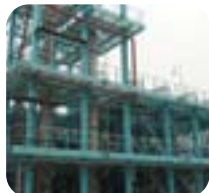
建設中の 石油化学廃水処理プラント
