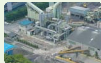
掘削土のリサイクルプラント
