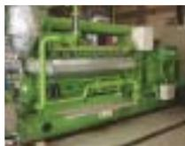
コージェネレーション廃熱を用いたバイオガス発電
