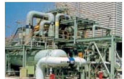
冷熱発電付トライエックス式気化器
