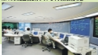
ガスの供給監視を行っている中央保安指令部
