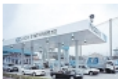
ガスステーション
