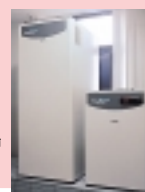
右が燃料電池、左が貯湯槽
