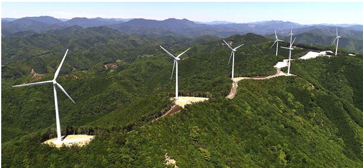
図-1 印南風力発電所
