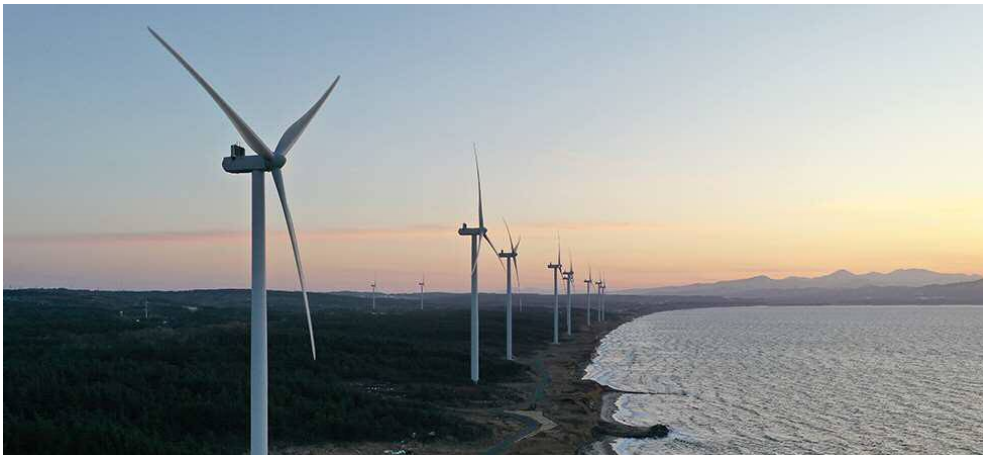
図-3 野辺地陸奥湾風力発電所
