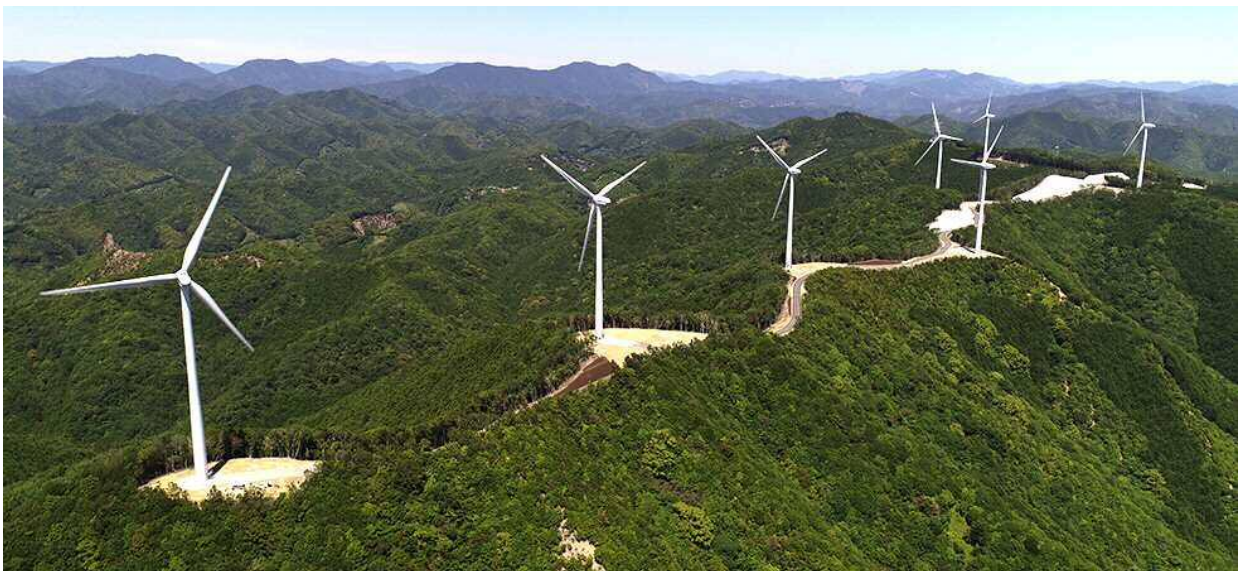
図-1 印南風力発電所
