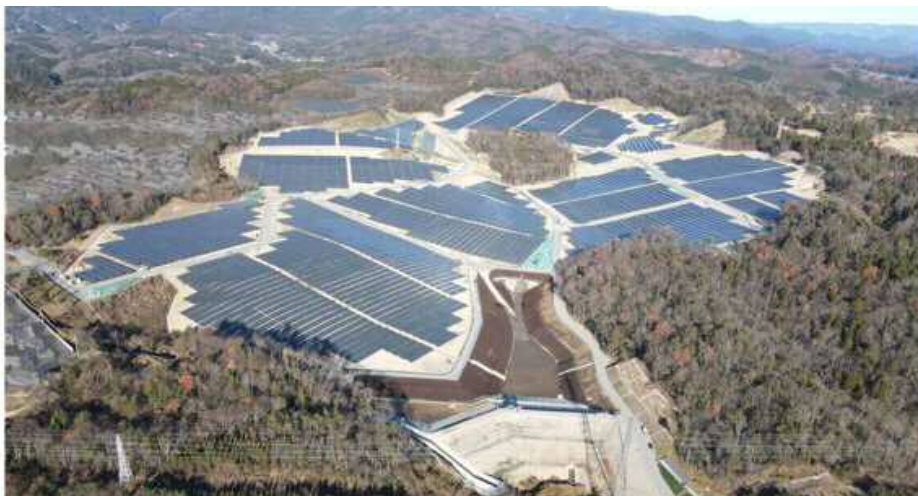
図-6 茨城県北茨城市磯原町特高発電所
